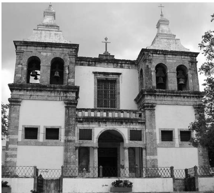
Figura 140 – Igrejas militarizadas (III) Santa Maria da Graça, Setúbal (c.1570), serliana, corpo central e 2 torres laterais. Fonte: Foto do autor
