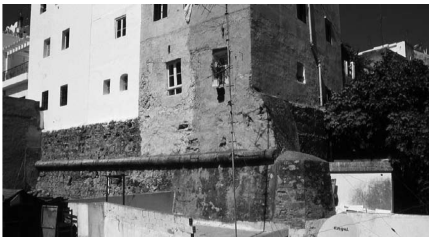
Figura 170 – Vestígio do baluarte sudoeste com o respectivo cordão de remate Fonte: Fotografia de Jorge Correia
