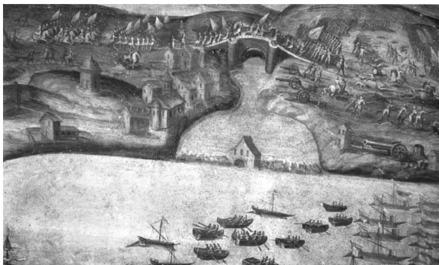
Figura 313 – Vista da ponte de Alcântara a partir do rio Tejo
